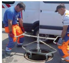
Pinza per telai pozzetti SRZ-M
