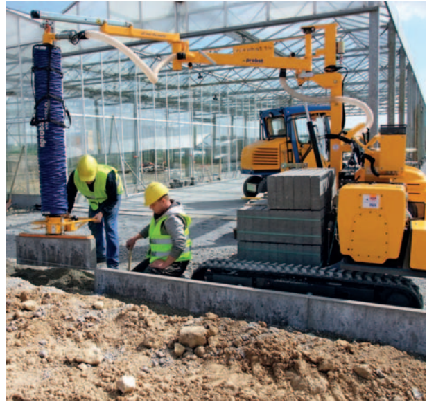
履带式路沿石安装机 TRANSMOBIL TM
