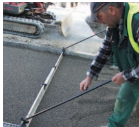
手拉式找平装置 TELEPLAN TP
