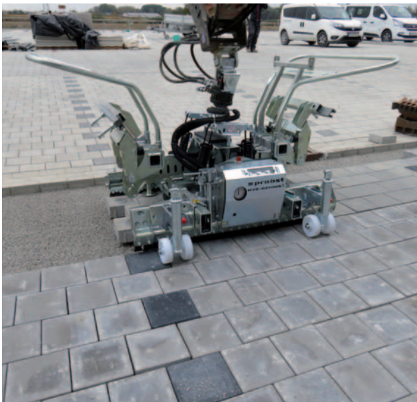
与挖掘机通用型液压铺装夹具 HVZ-GENIUS-II
