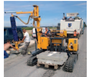
履带式路沿石安装机 TRANSMOBIL TM
