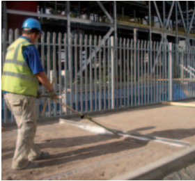
手拉式找平工具 EASYPLAN EP-UNI
