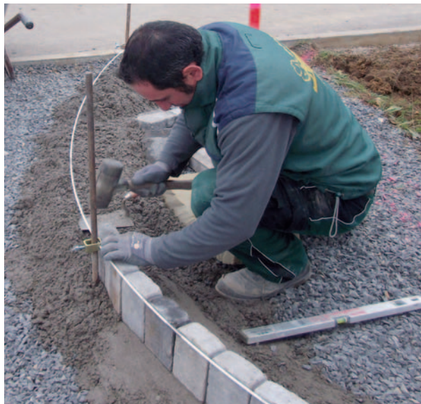
曲线打标器套件 FLEXMARKER-KIT FMK
