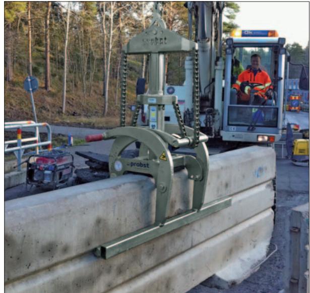
预制混凝土制品夹具 FTZ-GBA-S
