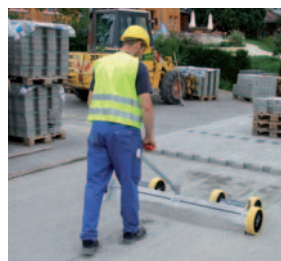
手拉式找平装置 LEVELFIX LF-125/215
